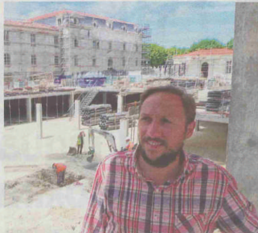
Stéphane Ruck, devant, au loin, la toiture où œuvrent les couvreurs. PHOTO D. B.
