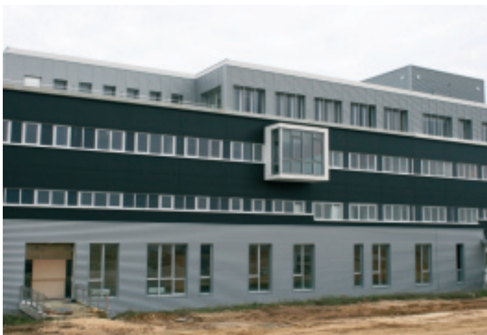
La façade sud
