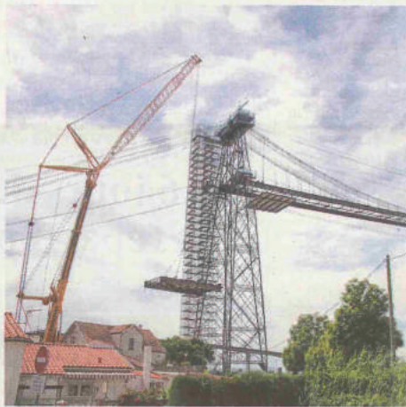
Le Transbordeur commence à tomber le tablier, ici côté Échillais.
