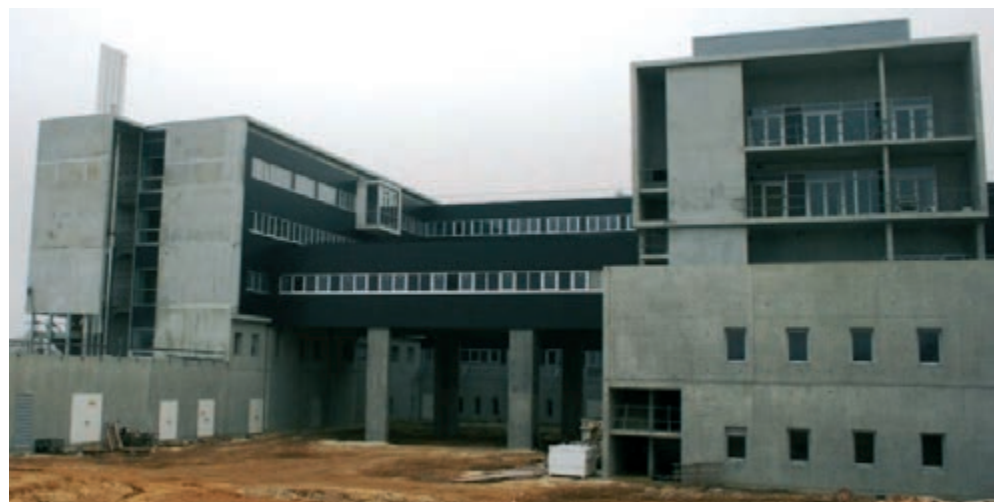
La façade ouest (la cour logistique)
