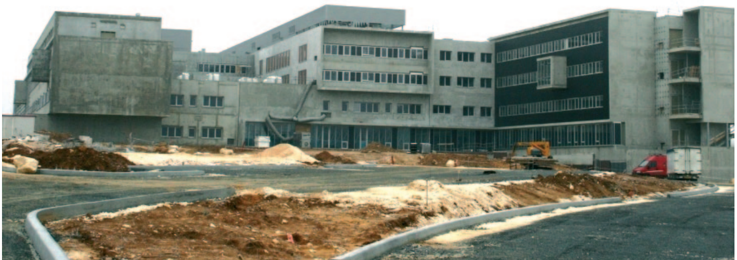
La façade est (l'entrée principale)
