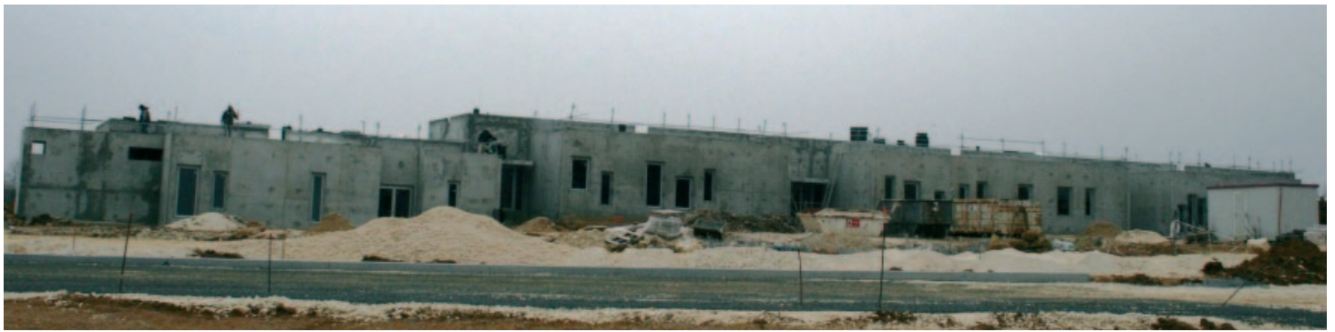
Le bâtiment de santé publique
